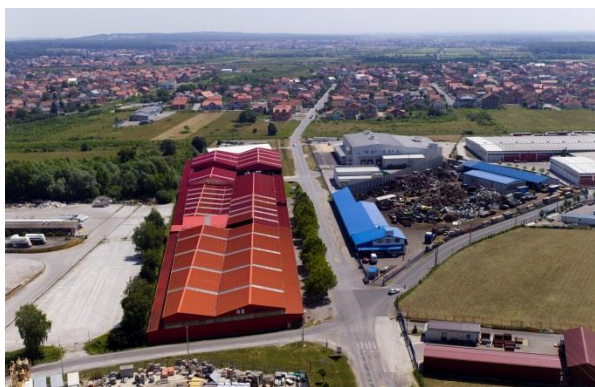
Lokacija postojećeg reciklažnog dvorišta na križanju Industrijske i Savske ceste - pogled iz zraka
